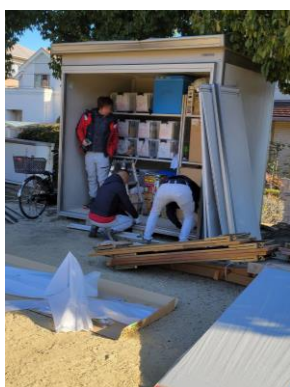
扉交換 ~ 蹠陀山公園
