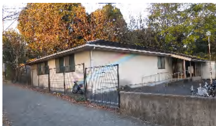
解体され新図書館に合築される集会室棟
