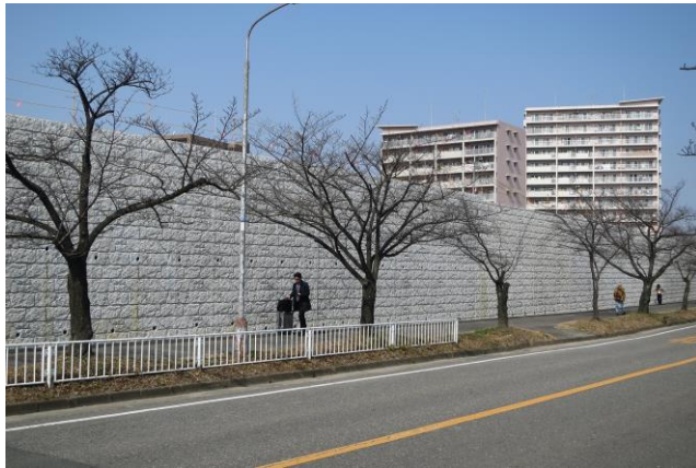
桜通りの擁壁が完成
