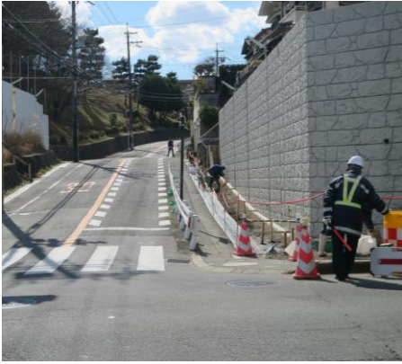
定見通りの擁壁、茶色の部分が拡幅された歩道
