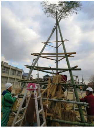
とんど櫓の組立て作業
