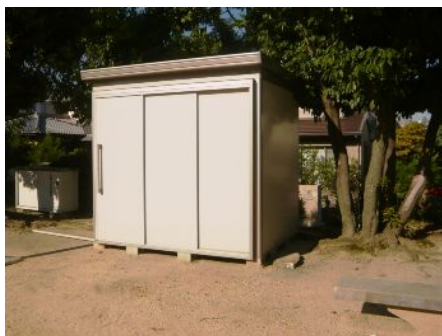
蹉跎山公園の自主防災倉庫
