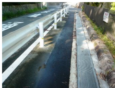
改修された歩道部分
