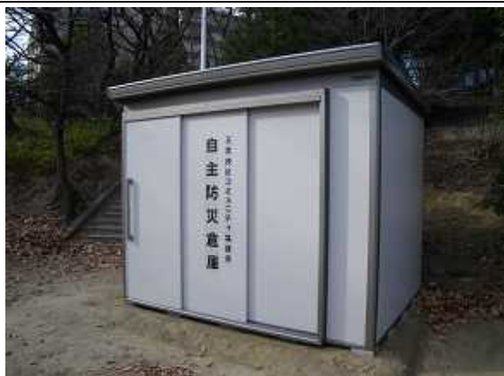
淀見公園の防災倉庫
