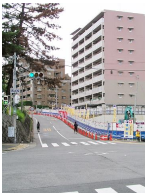
写真は工事中の歩道
