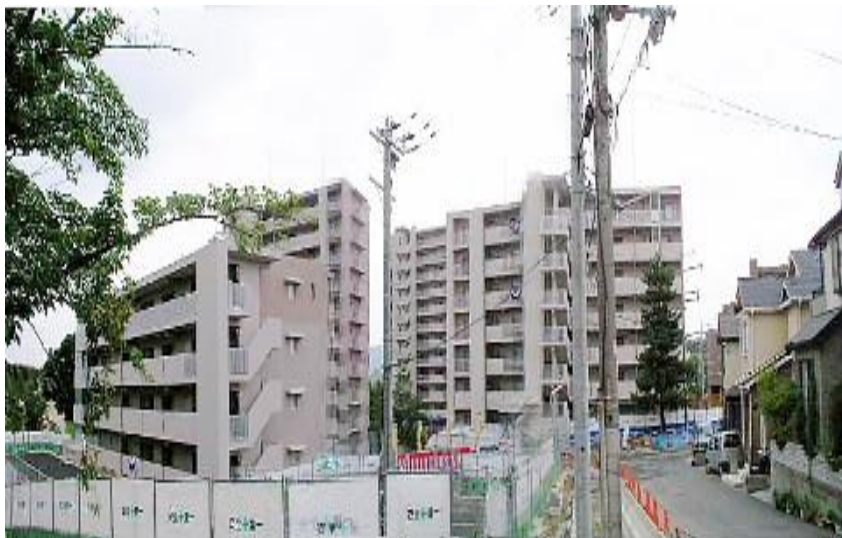
写真は建設中のさくらぎ街 (C20棟より写す・右は7丁目の新住宅)
